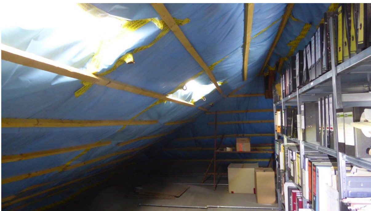
Abb. 8: Dachboden des zentralen Gebäudes
